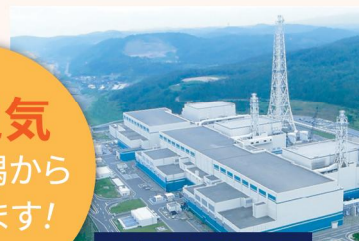
柏崎刈羽原子力発電所
