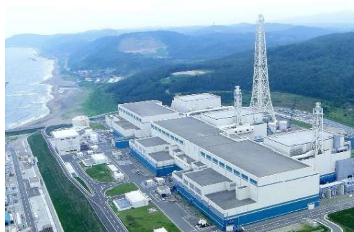
柏崎刈羽原子力発電所(5～7号機側) 出典:東京電力HP
