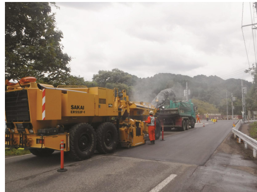
舗装補修工事状況
