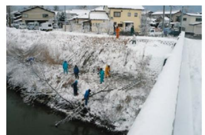
河川堤防の伐木
