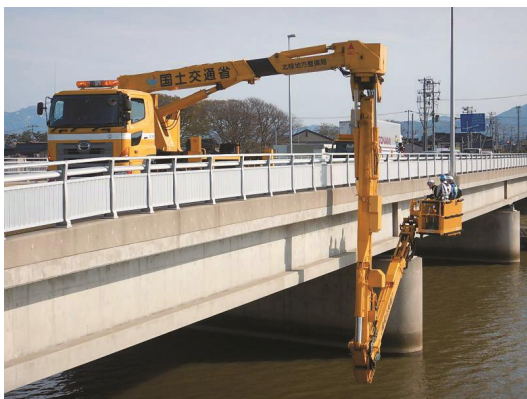
橋梁点検状況
