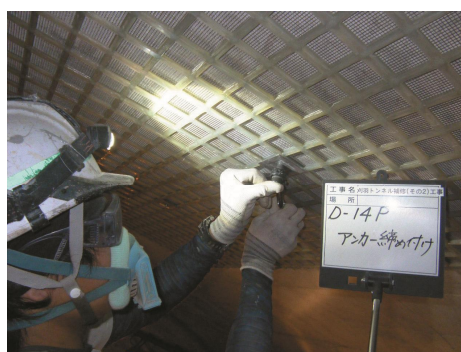
トンネルの補修状況
