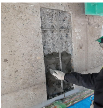
橋梁の補修状況
