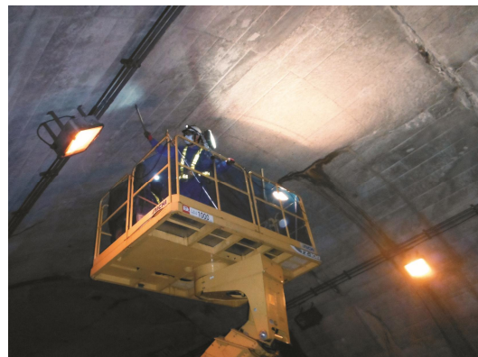
トンネル点検状況
