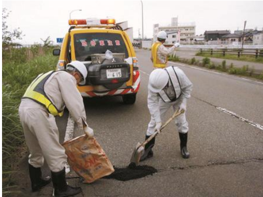
道路パトロール状況
