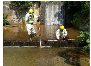
技術者による砂防施設点検 大野沢川（長岡市山古志種苧原）
