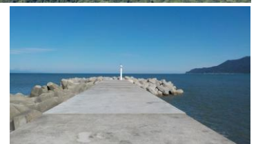
防砂堤のブロック据付工
