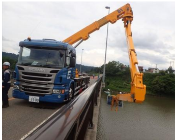
橋りょう点検車による点検 西倉橋（長岡市西川口）
