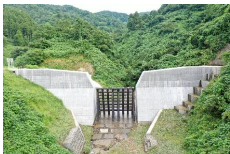
土石流対策 (砂防えん堤工) 浄土川第6号 (長岡市渡沢町)
