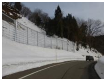
雪崩防護柵の設置状況 一般県道天納川口線(長岡市川口牛ヶ島)
