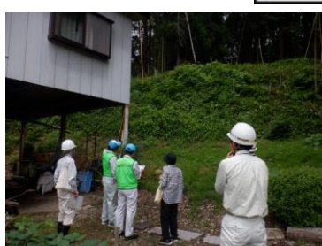
土砂災害特別警戒区域点検 見附市元町
