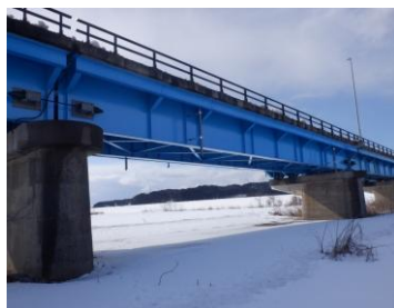
塗装塗替状況 与板橋（長岡市与板町）
