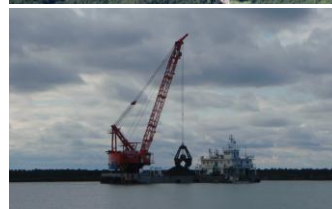
航路泊地浚渫工事
