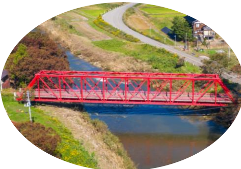
不動沢橋 長岡市不動沢
