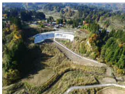
地すべり対策 (法面工、水路工) 新山地区 (長岡市東中ノ俣)
