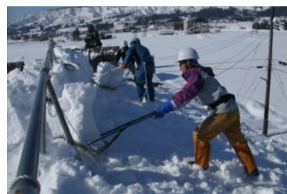
命綱固定アンカーを使用した雪下ろしの状況
