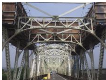
補修工事状況 長生橋（長岡市大島町）
