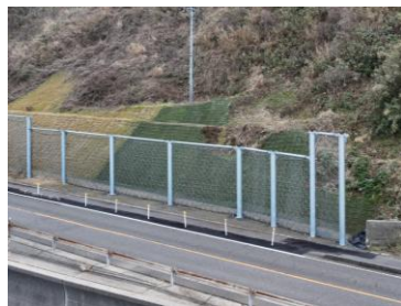
崩壊土砂防護柵の設置状況 一般国道402号(長岡市寺泊山田)
