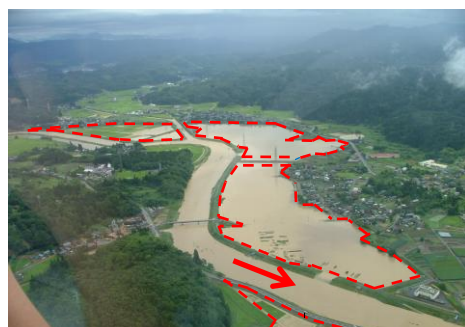
刈谷田川遊水地 (平成23年7月豪雨 遊水地越流状況)
