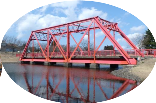
旧越路橋（保存橋） 長岡市浦
