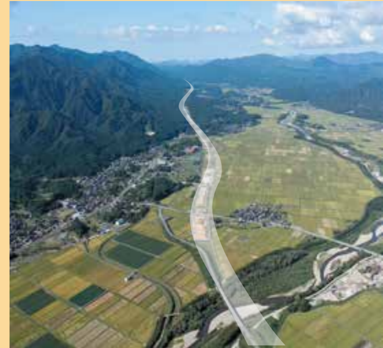
整備中の朝日温海道路 朝日まほろばIC付近
