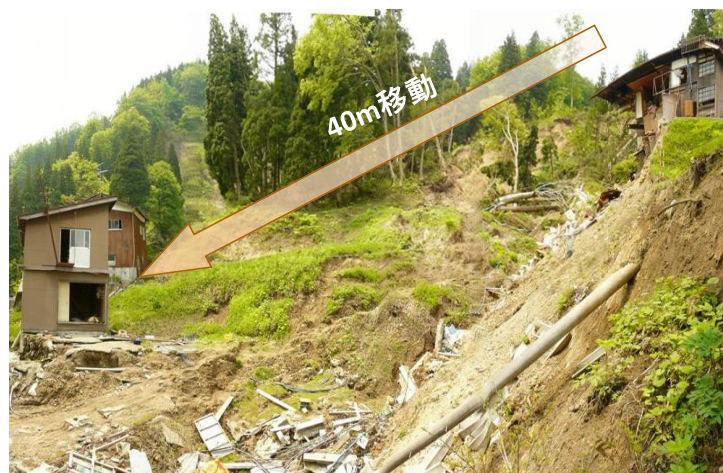
地すべり災害 H23春、人家半分が40m移動した。 H28復旧（防止区域名：中尾）
