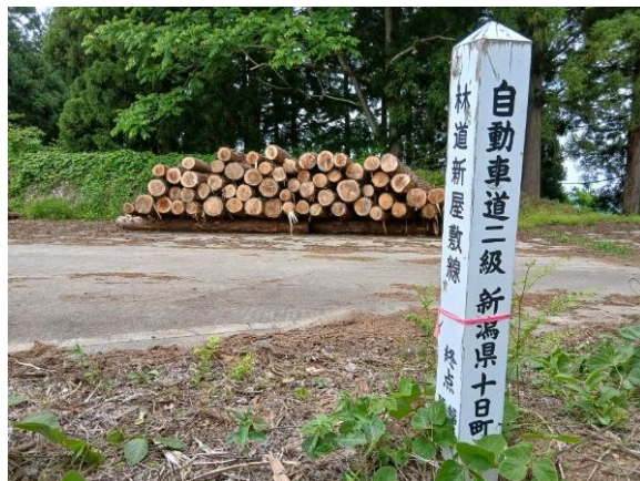
林道新屋敷線(十日町市)
