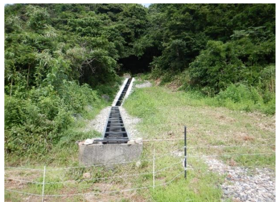
県単治山事業 施設修繕対策(村上市柏尾地内)
