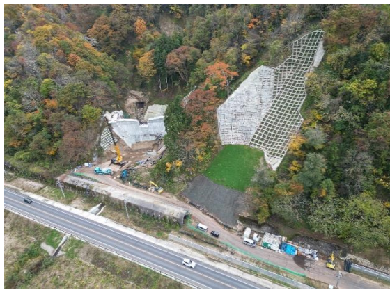
緊急総合治山事業 斜面崩壊対策(村上市貝附地内)
