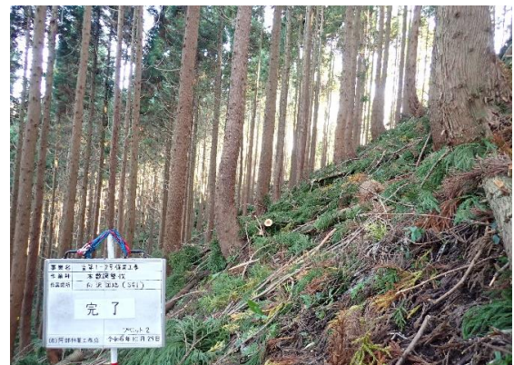
水源かん養保安林 保育事業(村上市赤沢地内)
