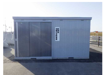
海老江水防倉庫 新設 (R2)
