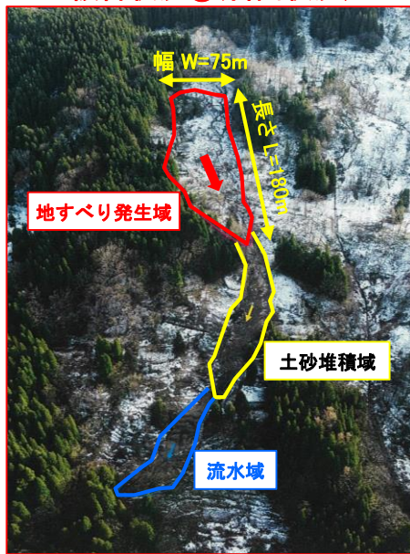
被害状況①(斜面状況)
