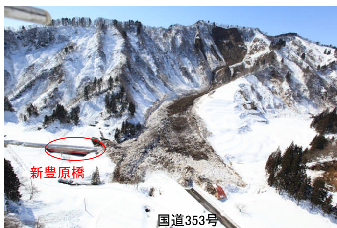
<被災直後の状況>
