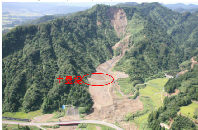
<応急工事(土塁堤など)完了後の状況>
