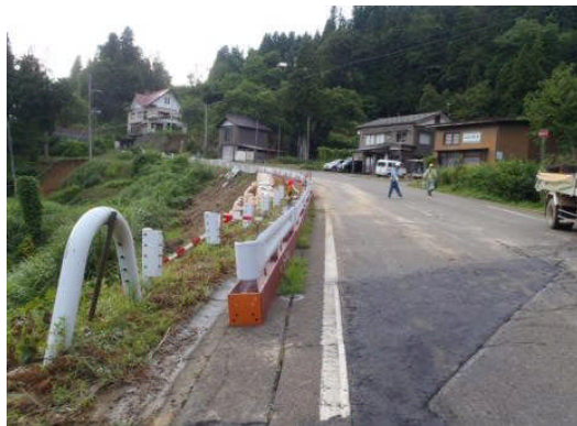
<応急復旧完了後の状況>
