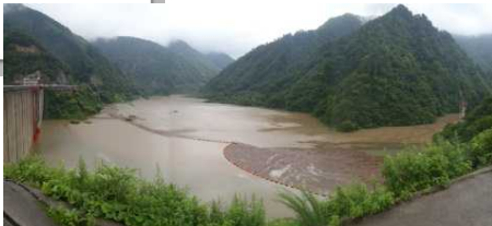
加治川治水ダム
