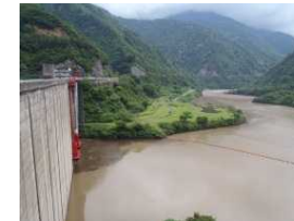
加治川治水ダム
