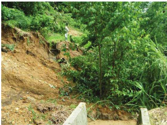
牛野尾谷地区:山腹用水路の崩壊
