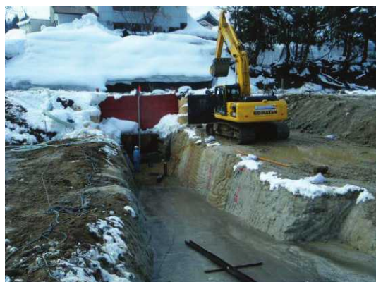
(右岸側埋設後)
