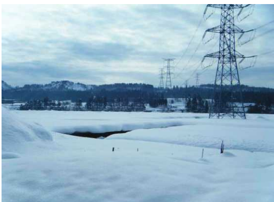
五十嵐川脇土砂流入箇所 (森町)
