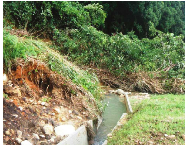
土砂堆積した用水路 牛野尾
