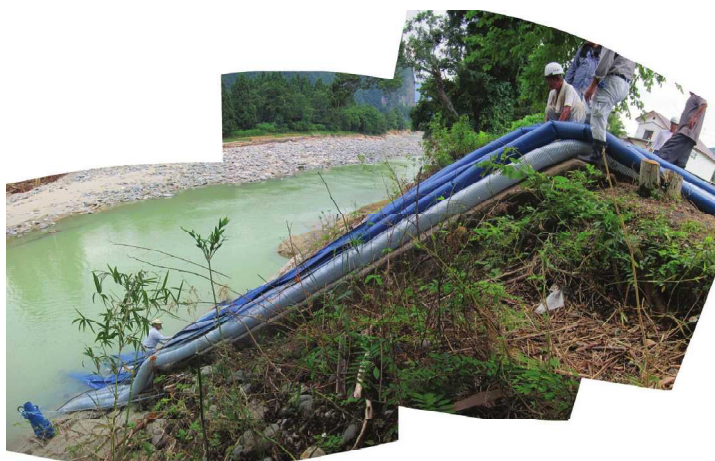
【応急仮設ポンプによる用水対応】
