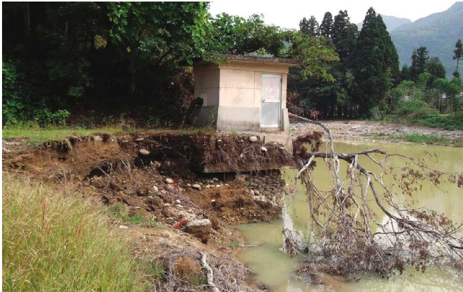
【五十嵐川の氾濫により洗掘被害を受けた揚水機場】 三条市塩野洲
