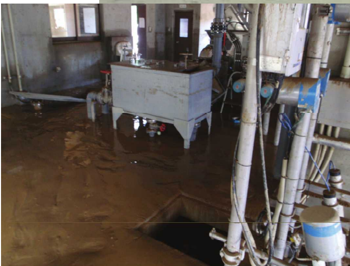
【集落排水「外谷浄化センター」の浸水状況】
