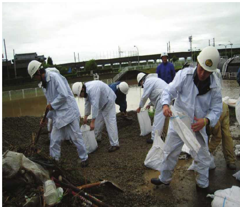
【土のう積み作業(7月30日6時30分～10時15分)】
