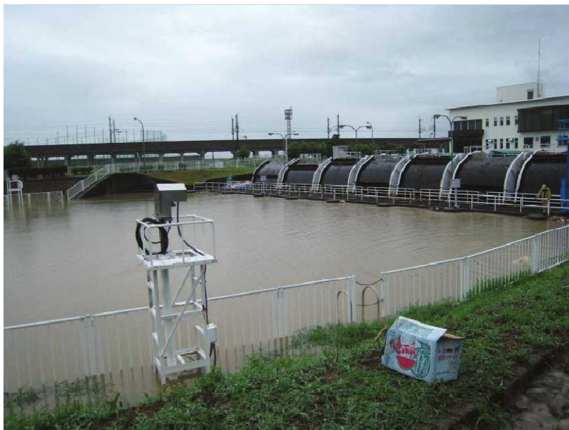
【水位が上昇した刈谷田川右岸排水機場】
