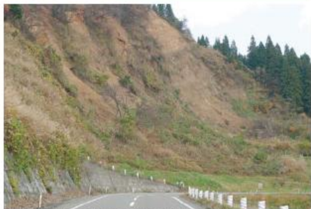
道路脇の急斜面。日頃から注意しておきたい場所です
