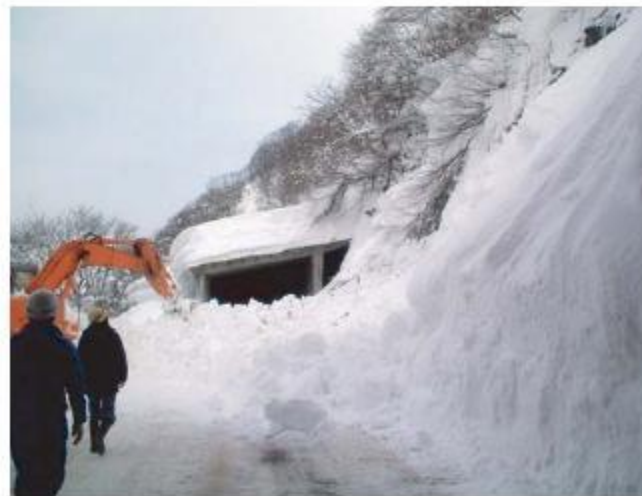
雪崩で通行止めになった国道405号(津南町)
