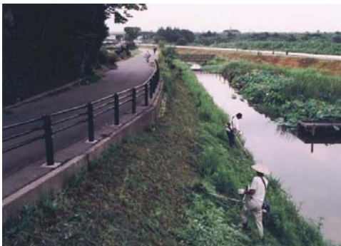
幹線排水路の草刈り作業
