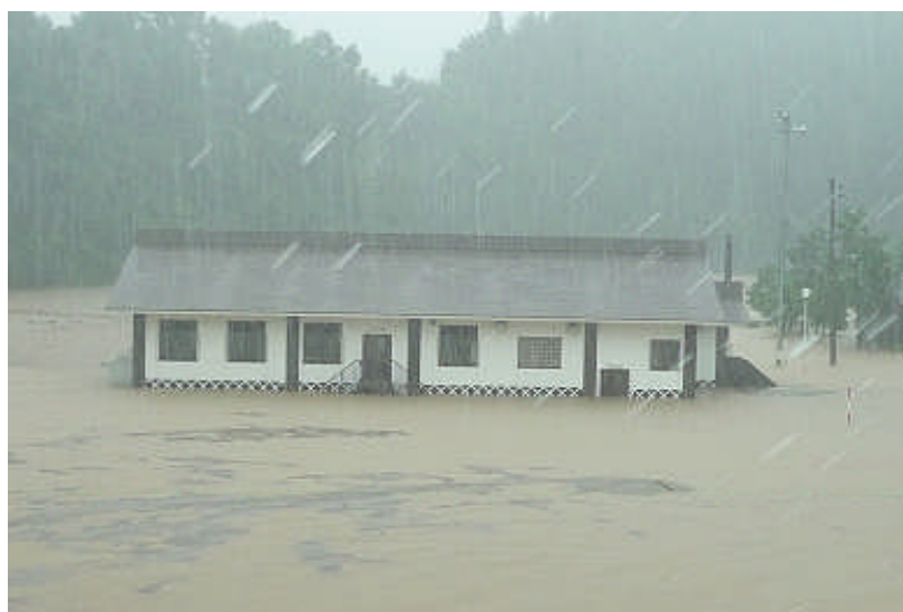
農業集落排水処理施設の浸水状況 三条市牛ヶ首
