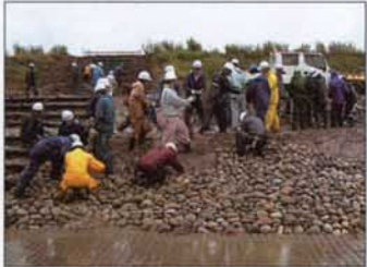
石張り護岸づくり
