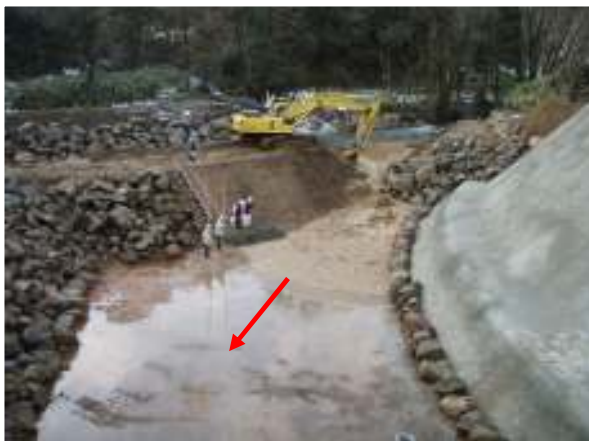
鵜川本川が仮排水路に流れ込む瞬間
