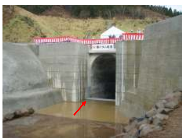
転流前の仮排水路呑口
