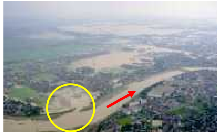
平成16年7月洪水 五十嵐川の堤防決壊状況
