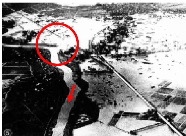
昭和36年8月洪水時の刈谷田川の決壊状況 ※ 8月5日豪雨被害状況(新潟県)より抜粋
