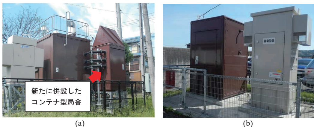
Fig. 2 設置局舎の外観
