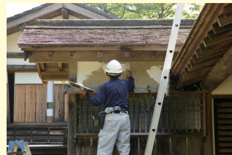
重要文化財旧長谷川家住宅の修理(長岡市) 長岡市提供
