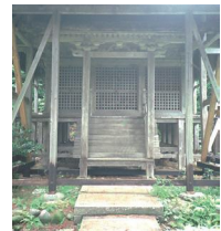
矢津八幡宮本殿
