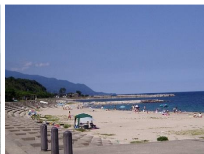
突堤や養浜により整備された 水辺空間の事例（両津港海岸）
