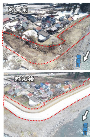
河川改修の事例
