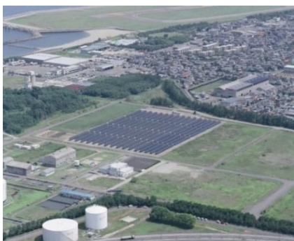
新潟雪国型メガソーラー発電所(新潟市)
