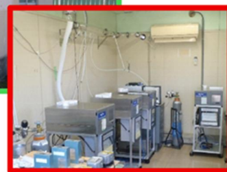
局舎内部の様子
