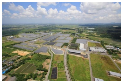
新潟東部太陽光発電所(阿賀野市)
