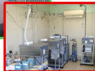
局舎内部の様子
