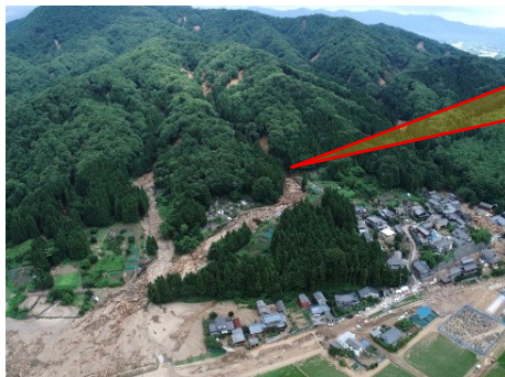
〈R4.8 新潟県北部豪雨による被災状況〉
