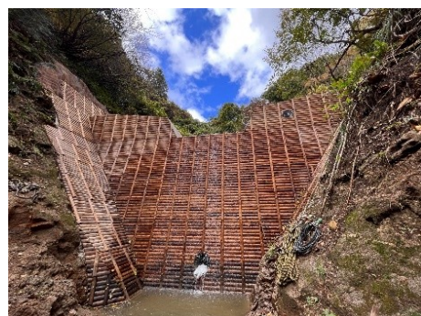
＜県産材を用いた木製型枠パネル＞
