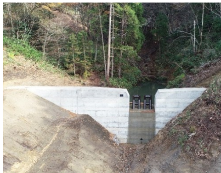
〈流木被害を防ぐ治山ダム〉
