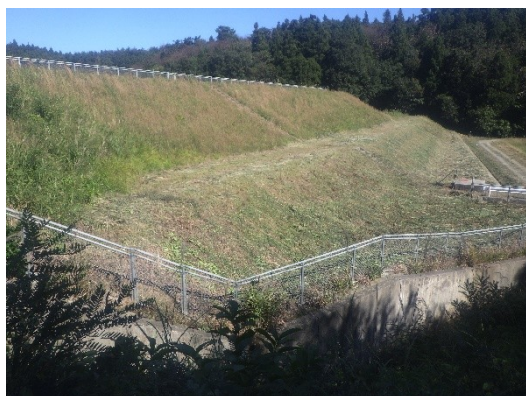
【ため池耐震工事前】
