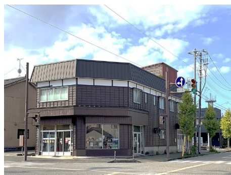
＜県産材による商店の外壁修繕＞
