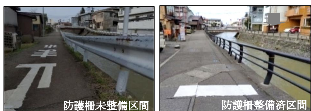
防護柵の整備状況
