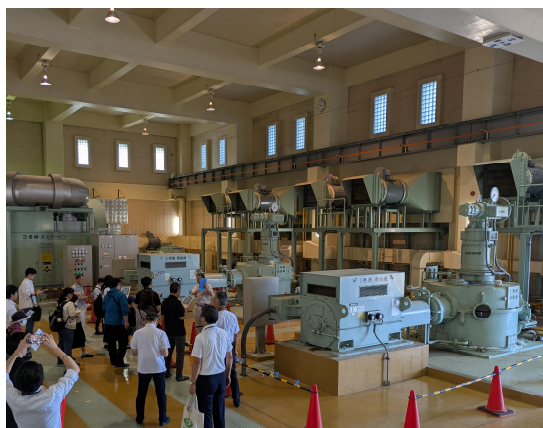
親松排水機場の見学
