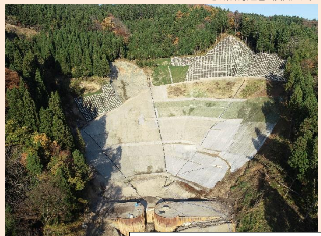
地すべり防止工事による復旧状況
