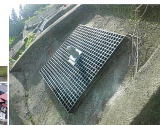
鉢内モルタル吹付 及び 鉄筋挿入工
