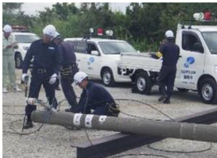
写真③ 倒壊電柱の除去訓練
