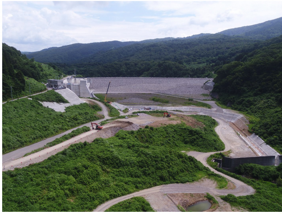
【上流側施工状況】2026年7月24日撮影
