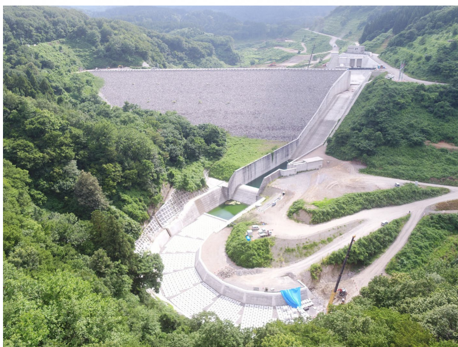
【下流側施工状況】2026年7月24日撮影
