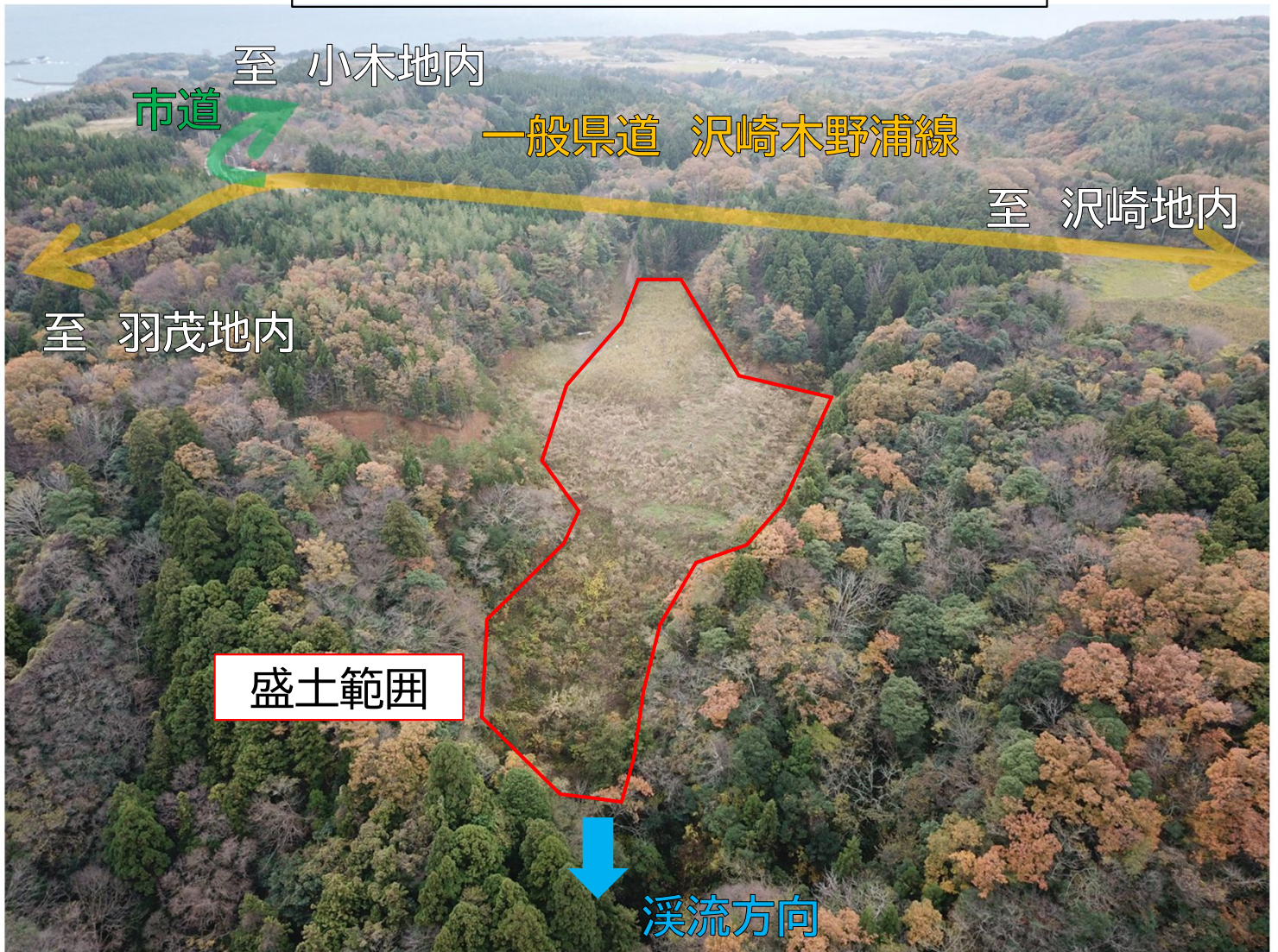
盛土撤去着手前(令和3年11月撮影)
