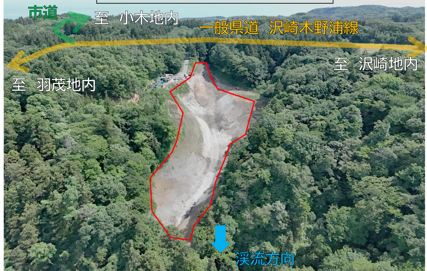
盛土撤去完了(令和8年6月末撮影)
