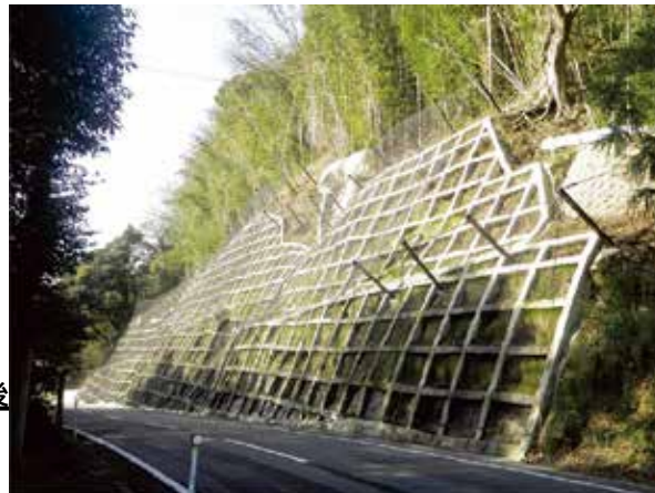
整備後 法面対策により 通行止めを防止
