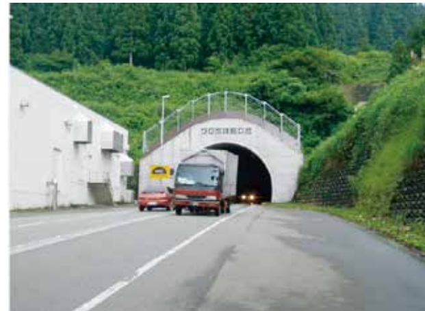
主要地方道十日町間塩沢線 大沢山トンネル(十日町市～南魚沼市)
