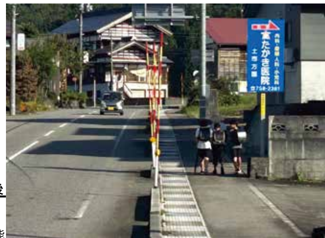
整備後 歩道整備により安全な 登下校が可能
