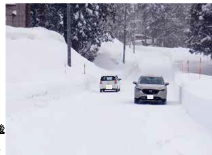
整備後 道路改良により 冬期間も安全な 通行を確保
