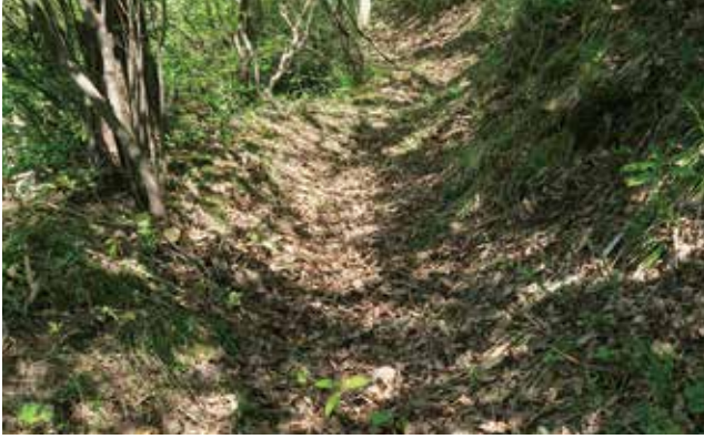
写真 2-9 導水路跡 [a]
