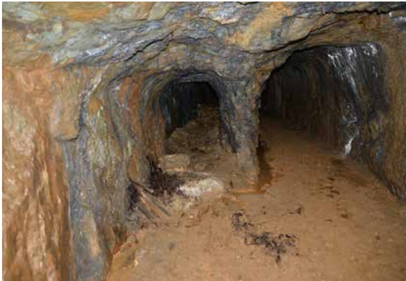
写真2-41 通気坑道（右）と本坑道（左）
