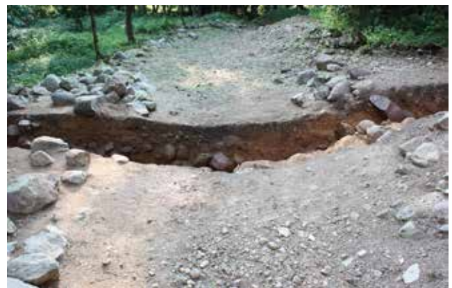
写真 2-14 配水路跡 (断面) [e]
