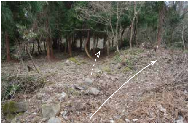
写真 2-13 配水路の流路変更 (石積みによる) [d]
