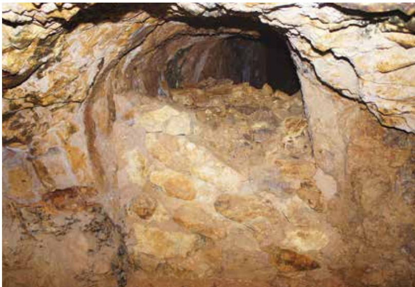
写真2-42 ズリと粘土で閉塞された連結坑
