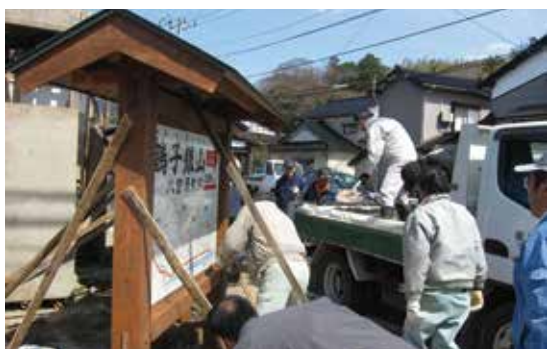
案内板の設置
