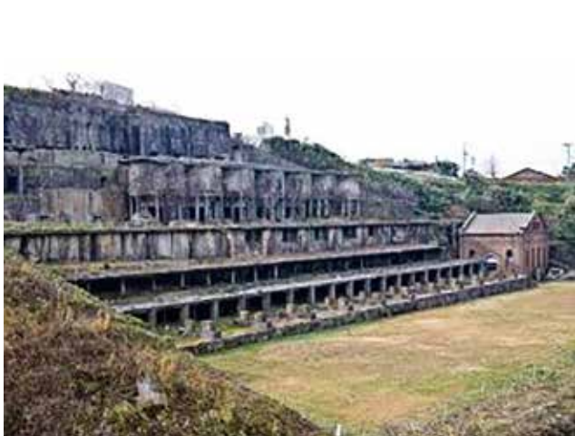
Fig.6 北沢浮遊選鉱場の遺構
