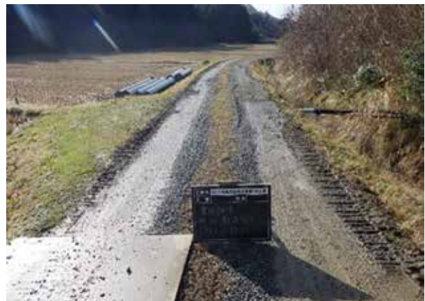
Photo.4 水道管の敷設後
