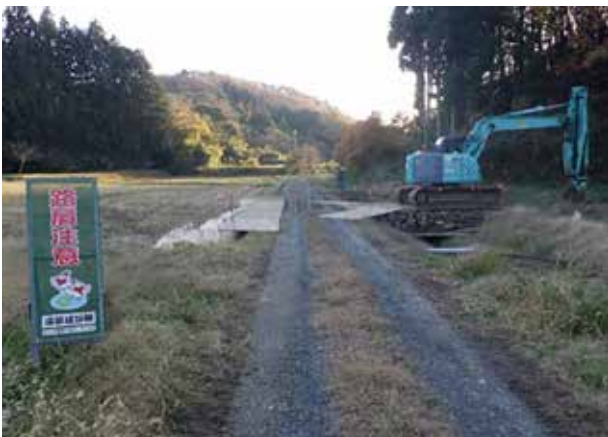
Photo.3 水道管の敷設前
