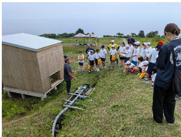
小水力発電施設の説明
