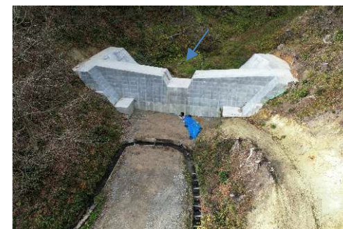
令和7年度施工状況
