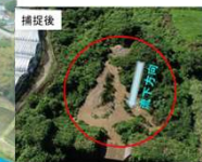
土砂を捕捉(令和2年8月撮影)
