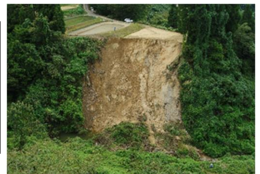
< 令和 6 年 9 月豪雨による 被害状況 ( 小千谷市小栗山地区 ) >
