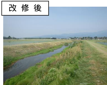
< 湛水被害防止のための排水路改修 >
