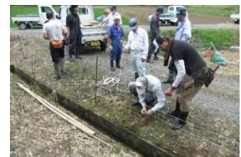
< 獣被害対策電気柵の設置 >
