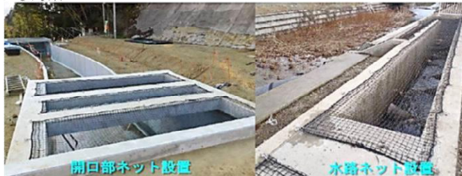
【転落防止ネット】転落してもネットが保護し脱出可能
