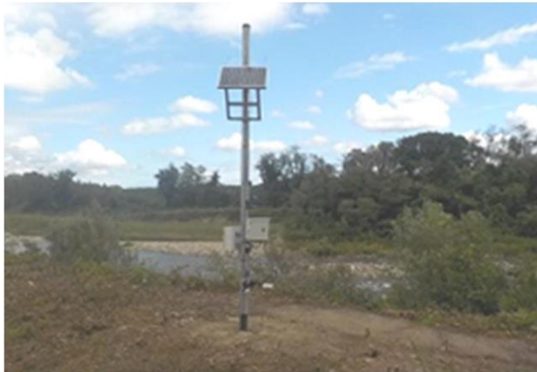
【クマ検知 AI カメラの設置状況】
