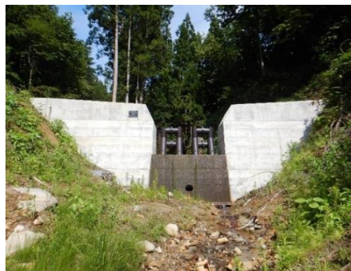
< R6.7に完成した流木捕捉式治山ダム工 （村上市小岩内地区） >
