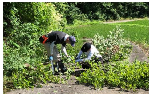
< 棚田みらい応援団による側溝泥上げ作業(十日町市) >
