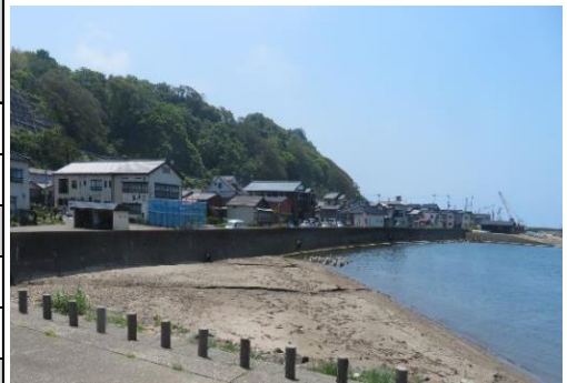
背後集落を守る海岸保全施設
