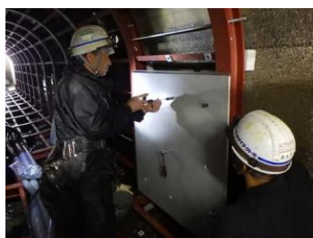
<コンクリート隧道のコンクリートパネル設置による補強>
