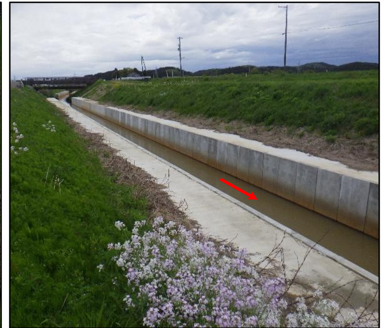
改修済区間 (大型排水フリームH2.6m×B4.2m敷設)
