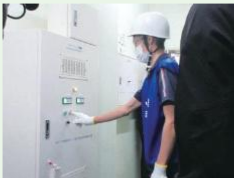
陽圧化装置の起動 (にしかりの里)
