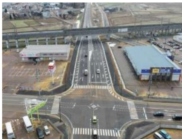
道路橋りょう整備（長岡市上条町）
