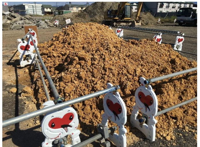
生コン残さをAC-096にて改良したものの
