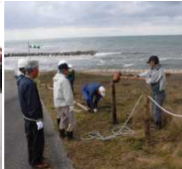
立入防止柵の設置
