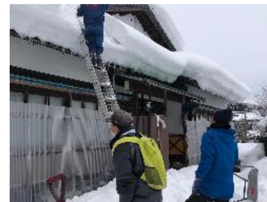
屋根雪下ろし作業の実施
