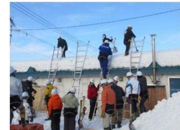
雪下ろし実技講習
