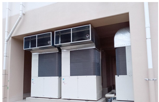
南魚沼警察署空気調和設備工事
